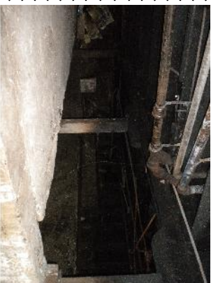
Crawlspace - SE Corner
