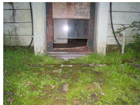
DOOR SILL COTTAGE A
