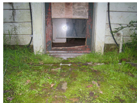
DOOR SILL COTTAGE A
