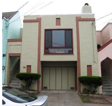
1487 31 st Avenue, L.L. & M.L. Wold, 1937.
