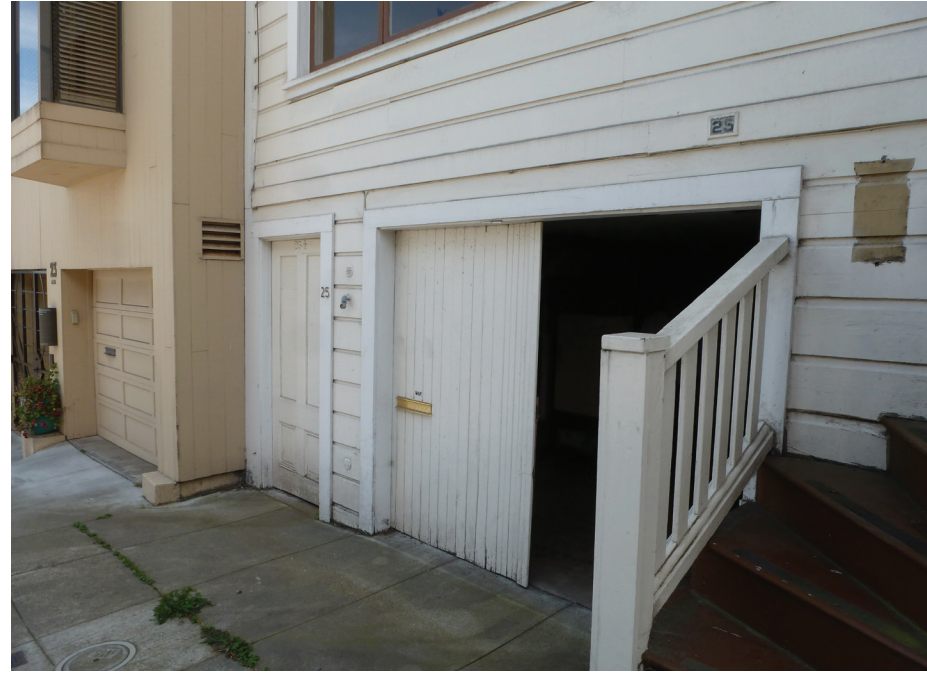
Existing garage door
