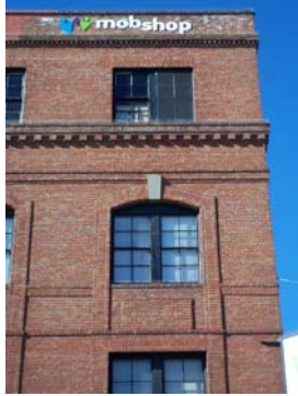
100_6047.JPG, 11/23/07, detail NE corner
